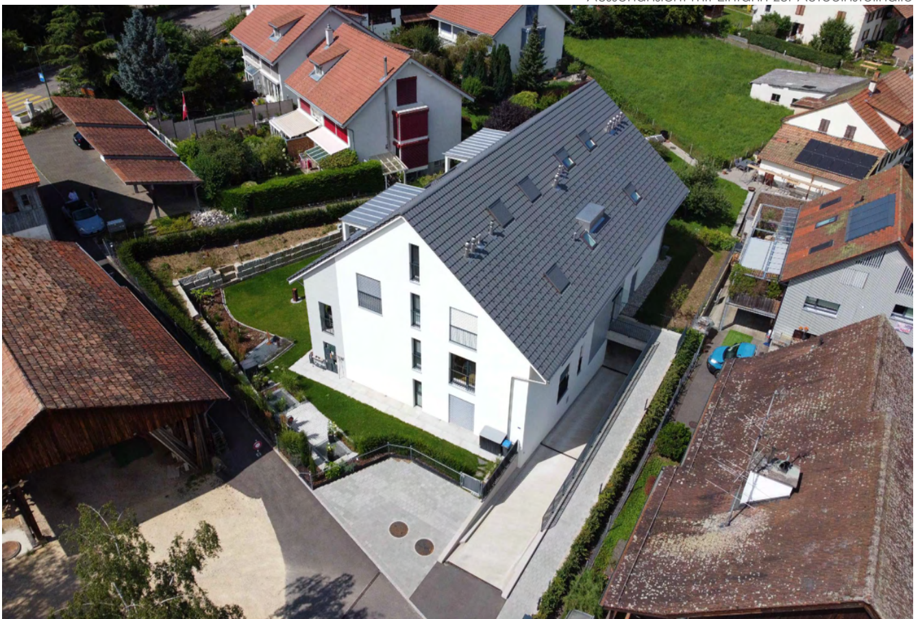
Aussenansicht mit Einfahrt zur Autoeinstellhalle
