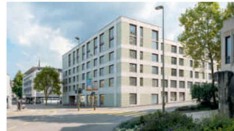
Kopfbau im Norden
