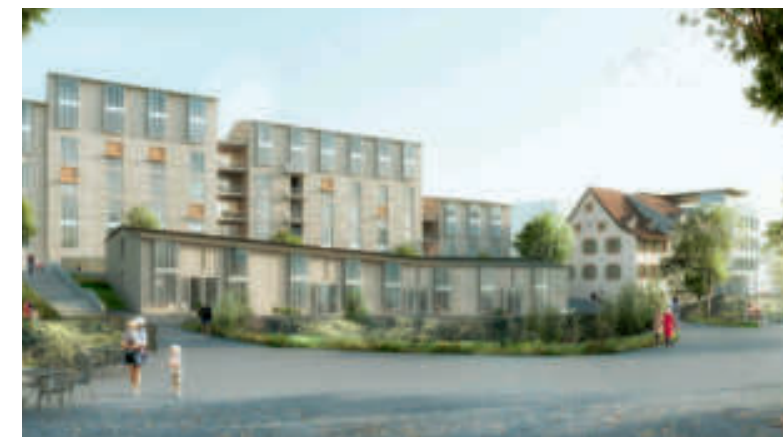
Blick von der Altstadt
